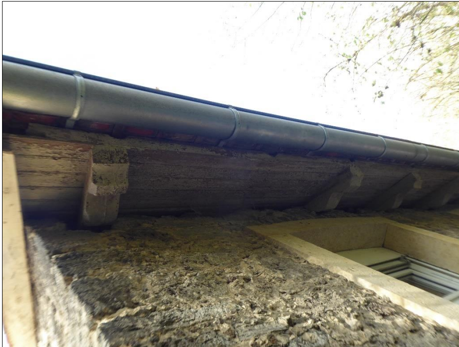
Abb. 7: Gebäude des Heimatmuseums mit Quartierpotenzial (Sommerquartiere) für gebäudebewohnende Fledermäuse
