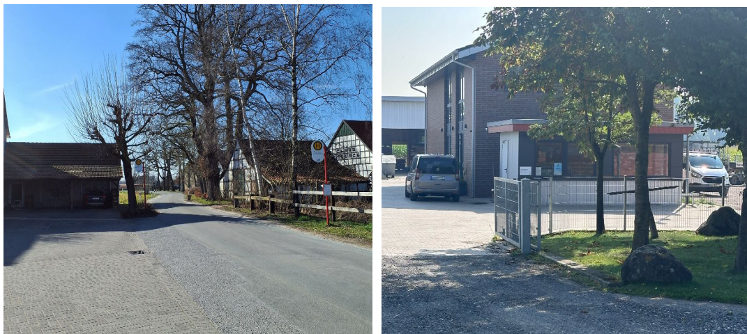
Abbildung 10 Asphaltierte Straße sowie gepflasterter Bereich (links) sowie Schotterfläche und geschotterter Bereich (rechts)
